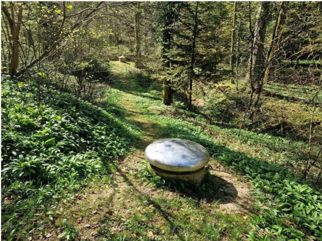
Foto 3: Schacht Quelle 2 (66.4.A) und 3 (66.3.A)
